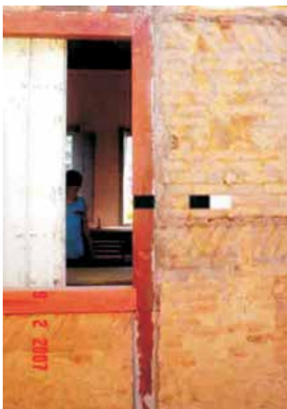
Figura 237 – Aparelho de comprido com travessas. Casa da Hera, Vassouras.
