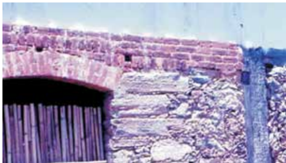
Figura 242 – Aparelho de comprido com junta a 1/3. Faz. Ribeirão Frio, Barra do Pirai. Fonte: CAUVR/UG, 1976.
