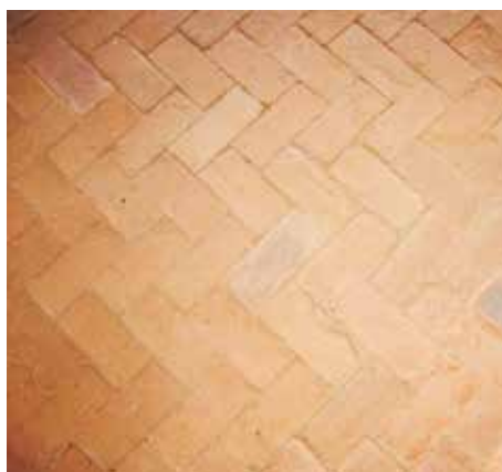
Figura 109 – Aparelho em espiga. Fazenda de Santana, piso, det. (Barra do Pirai, RJ) Fonte: Isabel Rocha, 2007.
