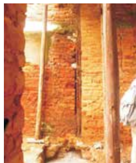
Figura 27 - Alvenaria de tijolo. Paraty, século XVIII.
