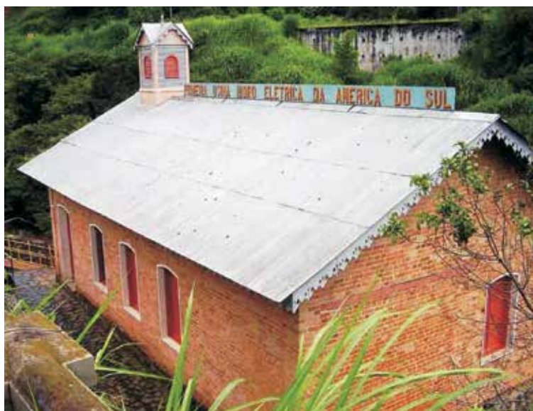
Figura 56 – Usina Hidrelétrica de Marmelos, Juiz de Fora, MG, 1889. Fonte: Fernando Mendes. http://www.flickr.com/photos/marmotafeliz/2368618887/
