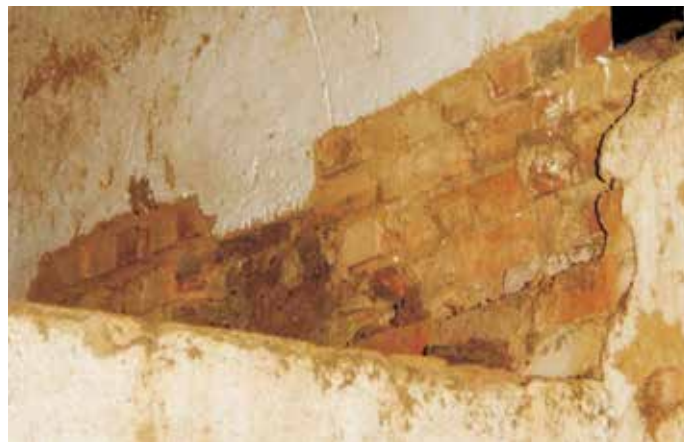
Figura 246 – Aparelho flamenco losango. Faz. Aliança, Pirai. Fonte: Noêmia Barradas, 2007, INEPAC, 2009.
