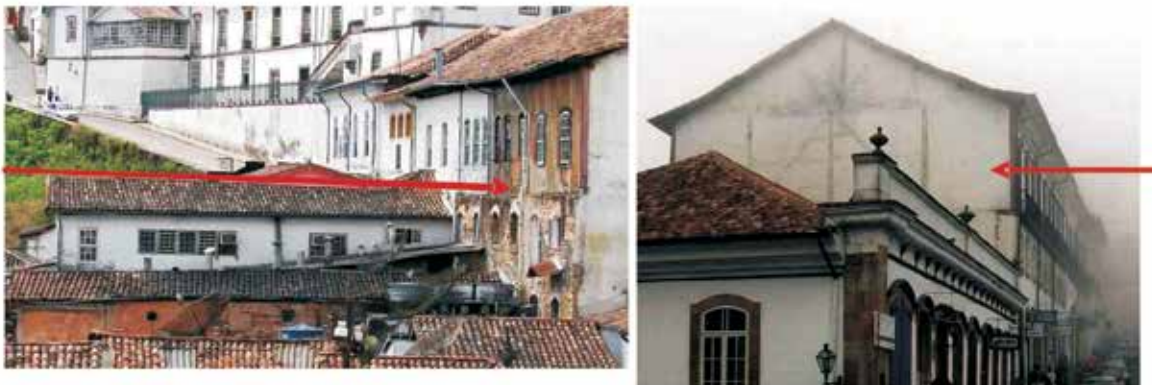
Figura 25 – Frente e fundos de casario na praça Tiradentes, Ouro Preto, séc. XVIII.
