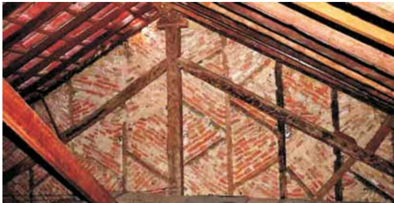
Figura 110 – Aparelho em enxaimel. Casa da Cultura, Paraty, RJ
