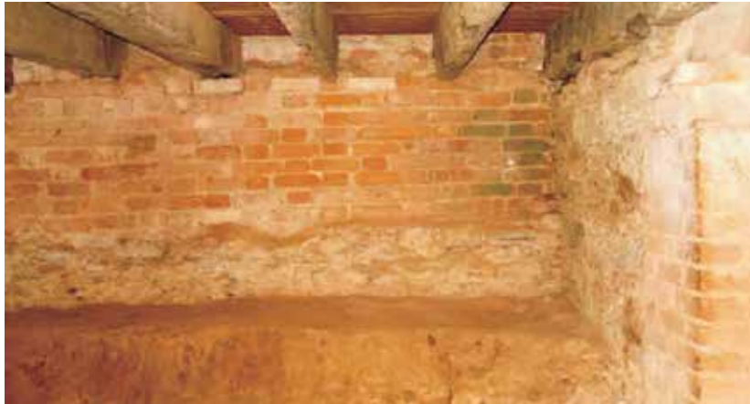
Figura 245 – Aparelho flamenco simples. Fazenda S. Fernando. Valença Fonte: INEPAC, 2009, p. 94.
