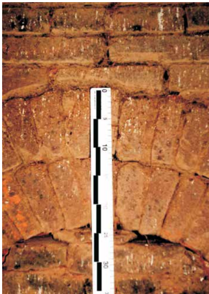
Figura 209 – Tijolo maciço, em arco. Faz. Pau Grande, Paty do Alferes, 1885. Fonte: Isabel Rocha, 2012.
