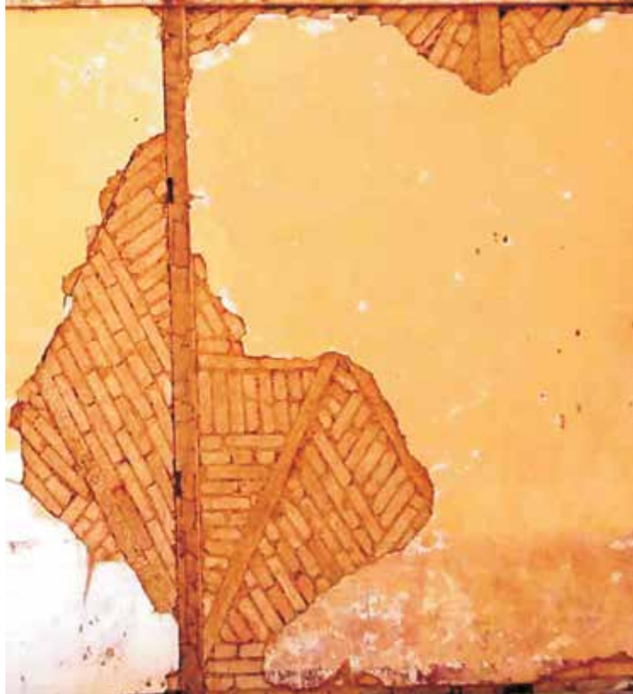
Figura 253 – Aparelho em enxaimel. Fazenda Monte Alegre, Barra do Pirai. Fonte: Isabel Rocha, 2011.
