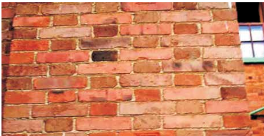
Figura 71 – Aparelho flamengo losango. Companhia Têxtil Brasil Industrial. Paracambi, RJ, 1871.
