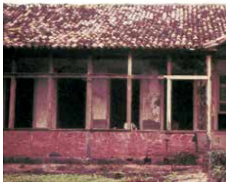
Figura 240 – Guarda-corpo de avarandado. Faz. Monte Alegre, Paty do Alferes. Fonte: CAUVR/UGB, 1976.
