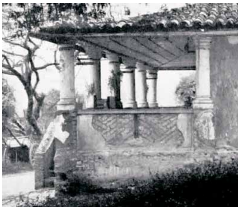
Figura 30 - Fazenda em Niterói, detalhe do guarda-corpo, século XVIII.
