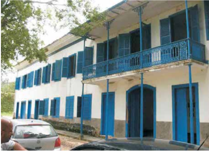
Figura 201 – Fachada principal. Fazenda Santa Mônica, Valença, > 1847.
