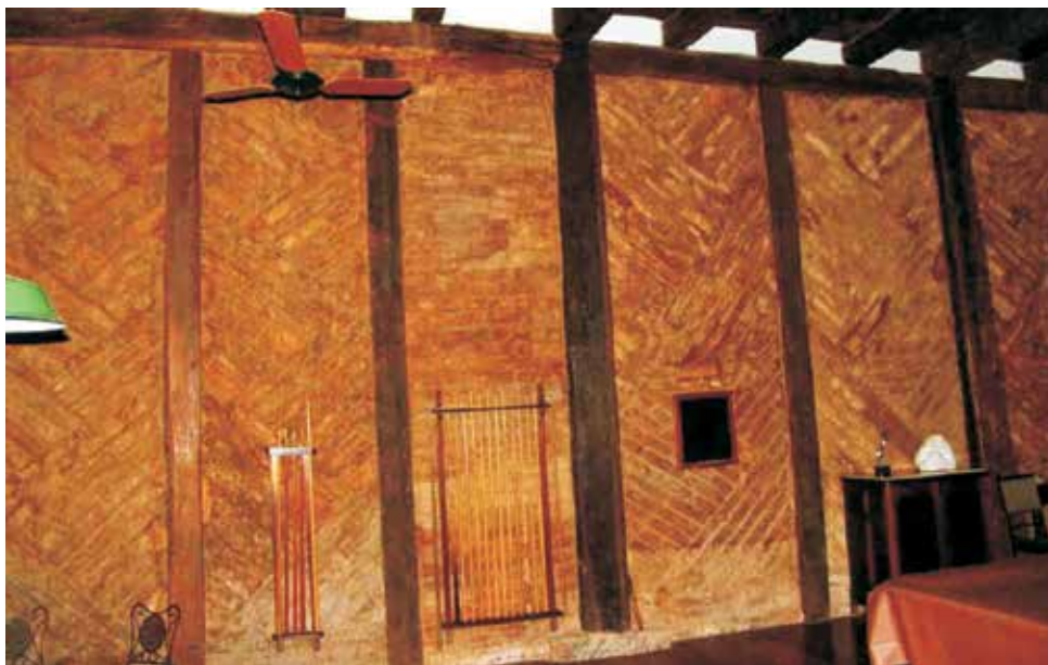
Figura 250 – Aparelho em espiga. Faz. Pau Grande (Paty do Alferes) Fonte: Ana Carolina Neves, 2012.
