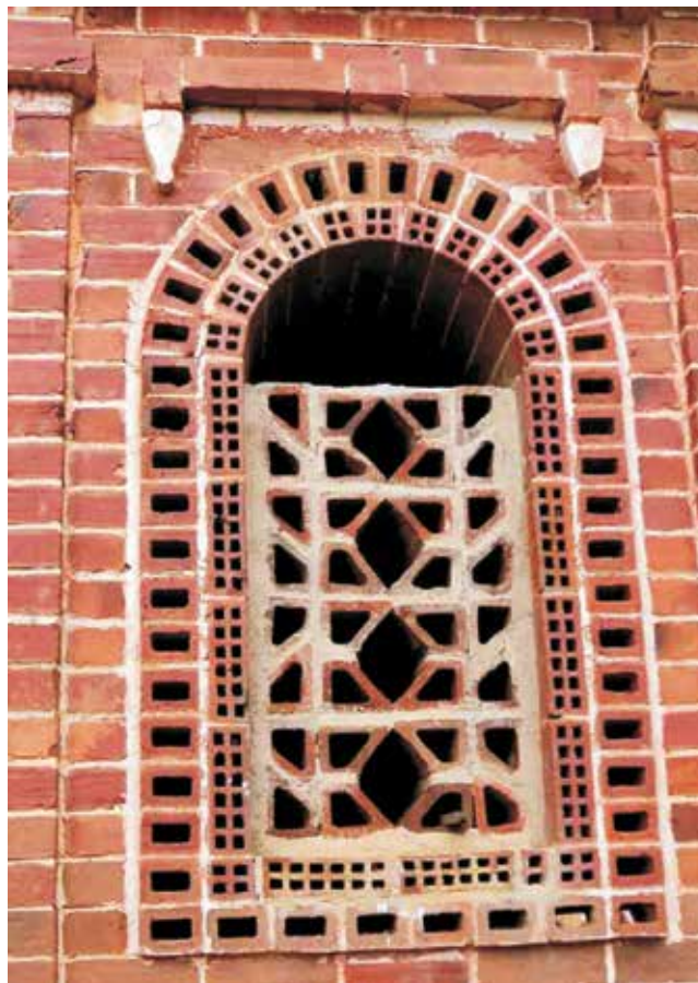
Figura 219 – Arranjo decorativo com tijolos furados e especiais.
